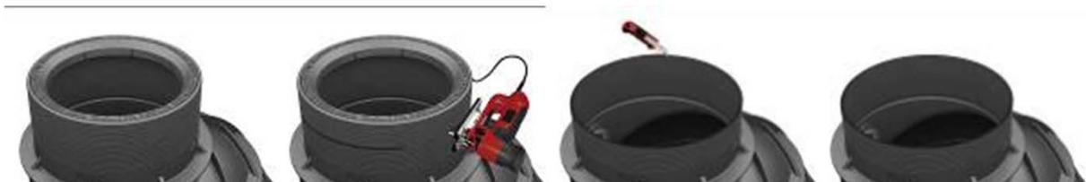
15.) Posare la piastra di ripartizione sul terreno con grado di costipamento pari o superiore al 98% secondo Proctor standard previsto dalla norma EN 14802:2005. Assicurarsi che la piastra non tocchi il pozzetto. L' elemento cilindrico terminale del pozzetto, che si infila per circa 10 cm nel foro della piastra di ripartizione deve avere una luce di minimo 2 cm su tutta la circonferenza. In caso di posa in acqua richiudere il geo tessuto sotto la piastra di ripartizione. (vedi figura punto 17)
